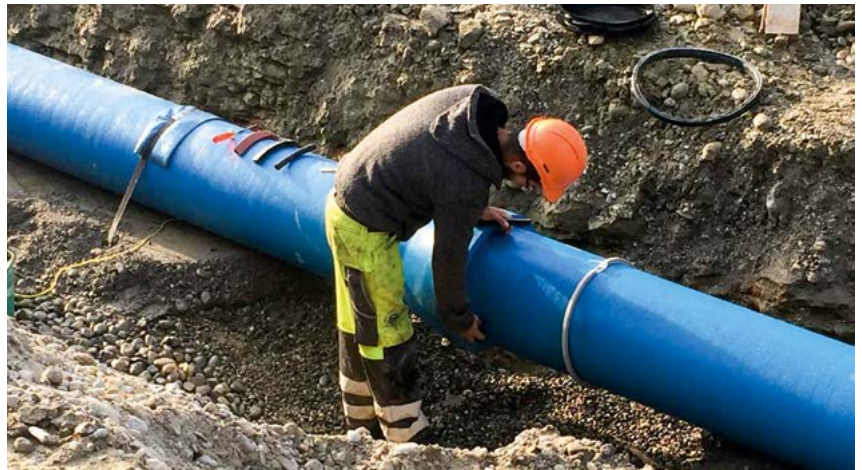
Sicherung der Rohre mittels einbetonierter Metallstreifen, gegen Auftrieb während dem Betoniervorgang.
