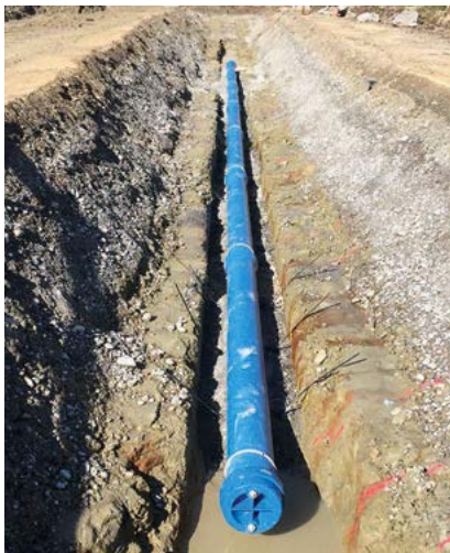
Einfräsung in den bestehenden Sandstein.
