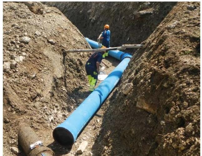
Dank der FZM-Ummantelung der Rohre konnte der Aushub ohne Kiesbett direkt wieder zum Verfüllen des Grabens verwendet werden.
