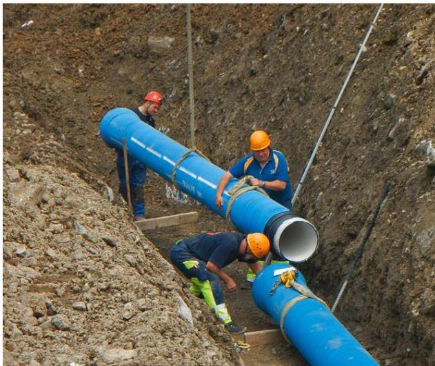
Einbau eines BLS/FZM-Rohrs DN 400.
