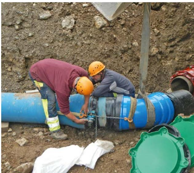
Montage eines MMK-Bogens mit Anschluss auf die alte, bestehende Leitung.
