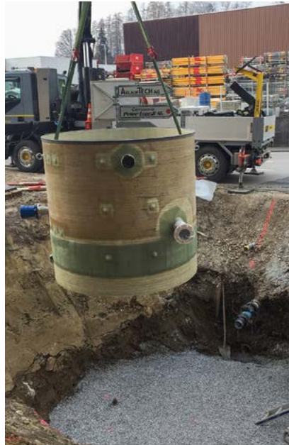
Versetzung des bereits vormontierten Druckreduzierschachts in der Gewerbezone First.
