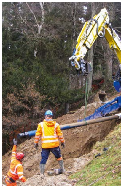
Rohrverlegung im Steilhang mit Hilfe des Baggers. Vorab wurden immer drei Rohre mittels Seilwinde in Position gebracht.
