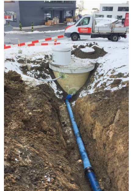
Gleichenfalls wird der Druckreduzierschacht an die bestehende Leitung angeschlossen.
