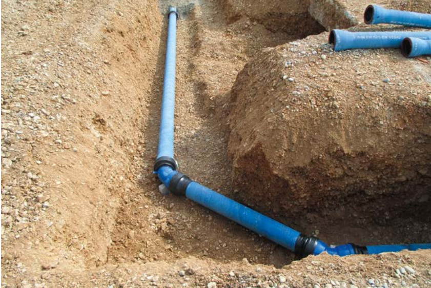
Trinkwasserrohre FZM-BLS DN 125 in Verbindung mit Doppelmuffenbogen im BLS Schub-sicherungssystem.
