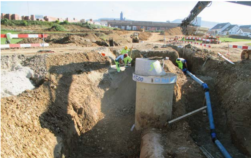
ENKE-Fertigschacht DN 1500, Trinkwasserrohre FZM-BLS 125/150 und Kanalrohre FZM-BRS 700, alles aus einer Hand: Hagenbucher!
