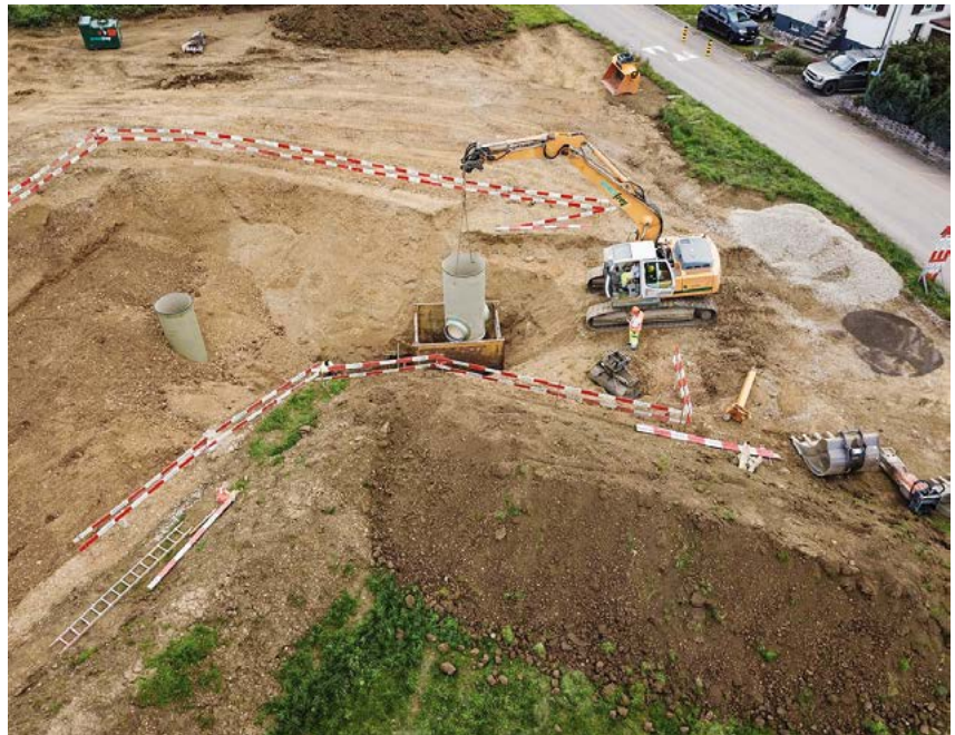
Versetzung eines ENKE-Fertigschachtes aus der Vogelperspektive. Insgesamt wurden 22 Schächte eingebaut.
